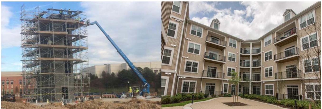
Construcción de Oxford Square.
