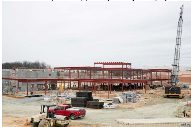
Construcción de la Nueva [Escuela Primaria] ES #42.
